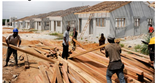
Chantier de construction de maisons d'habitation à Abidjan
