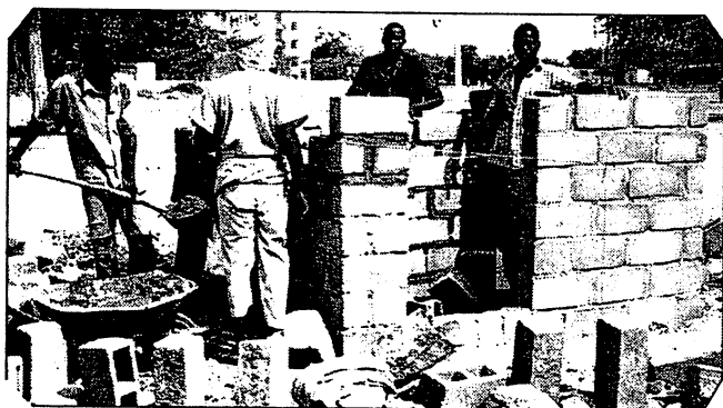
Construction d'une toilette publique au bord d'une rue
